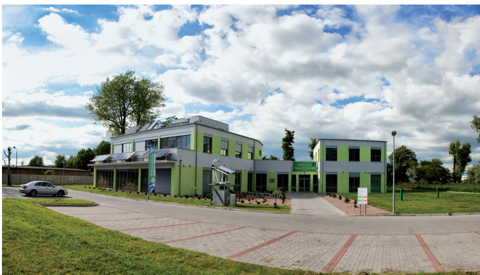
Centrum Technologii Energetycznych w Świdnicy
